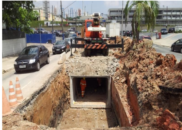
Figura 3: Galeria de drenagem
