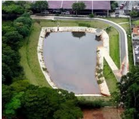
Figura 6: Bacia de retenção
