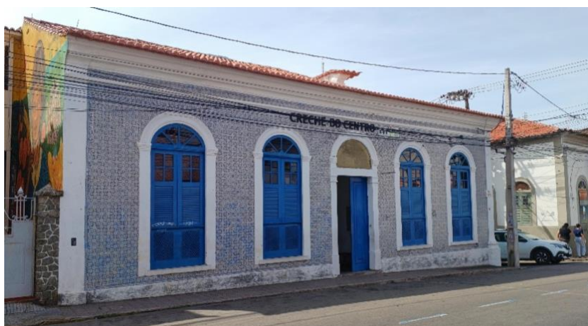
Figura 7: Fachada da Creche do Centro
