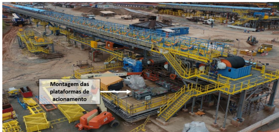
Figura 61 - Montagem da base skid.
