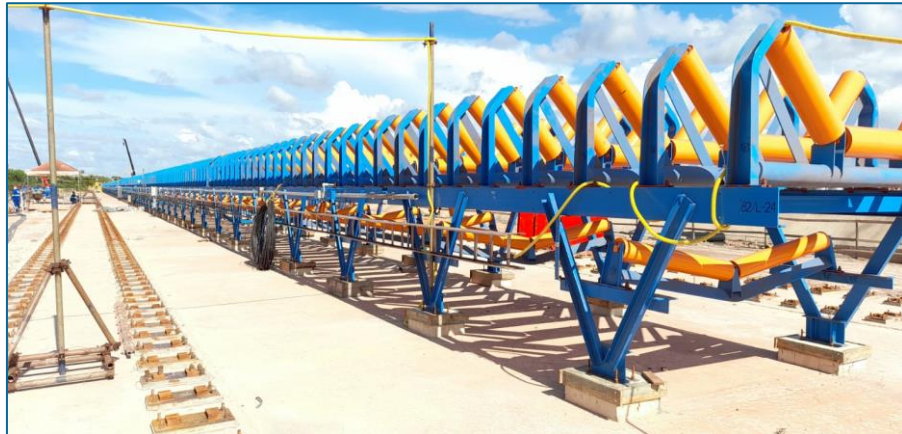
Figura 60 - Montagem dos módulos de mesas na berma.
