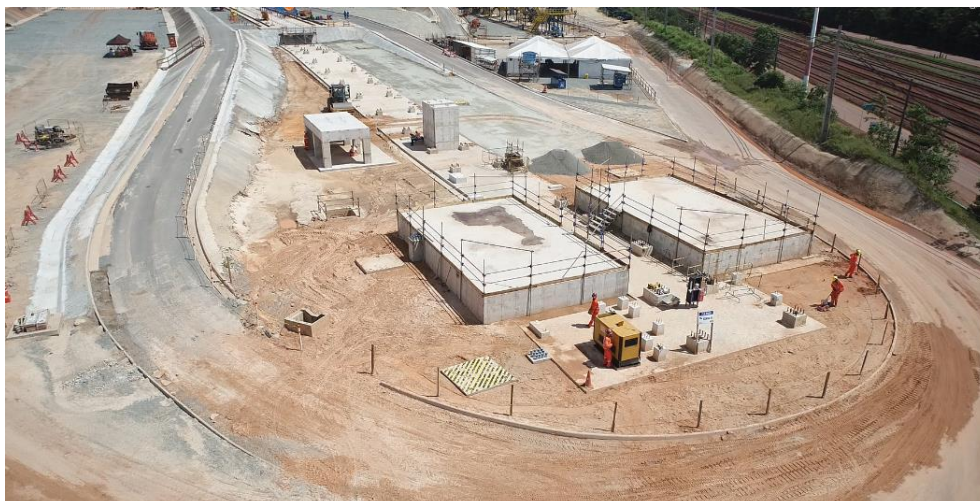
Figura 57 - Execução das bases civis - região da cabeceira do transportador.
