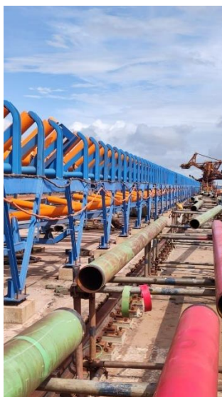
Figura 69 - Montagem de tubulações de SPCI e AID.
