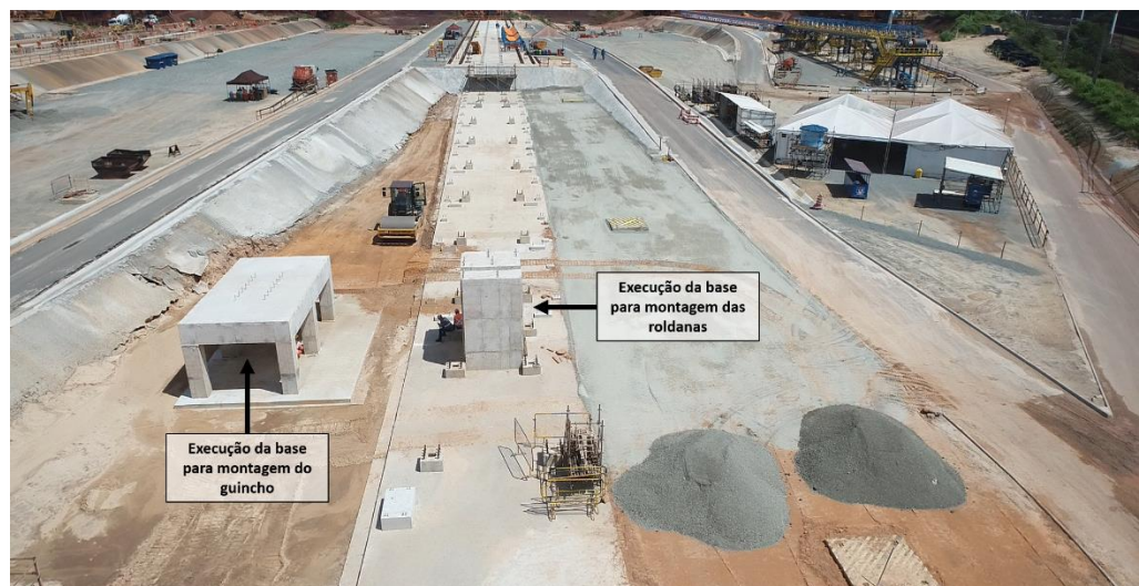
Figura 55 - Execução das bases civil para sustentação do guincho e roldanas – Planejamento 4D.
