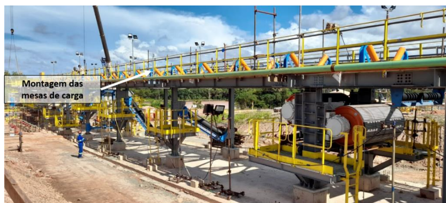
Figura 59 - Montagem das mesas de cargas sobre a cabeceira.
