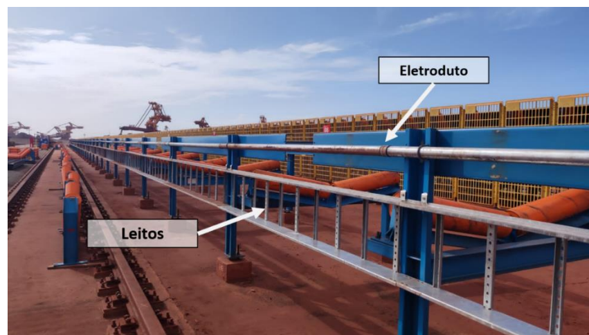
Figura 72 - Montagem de leitos e eletrodutos no transportador.
