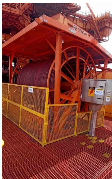
Figura 83 - Execução da montagem do novo enrolador de cabos.
