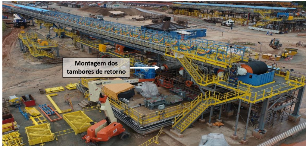
Figura 64 - Montagem dos quatro tambores de retorno.
