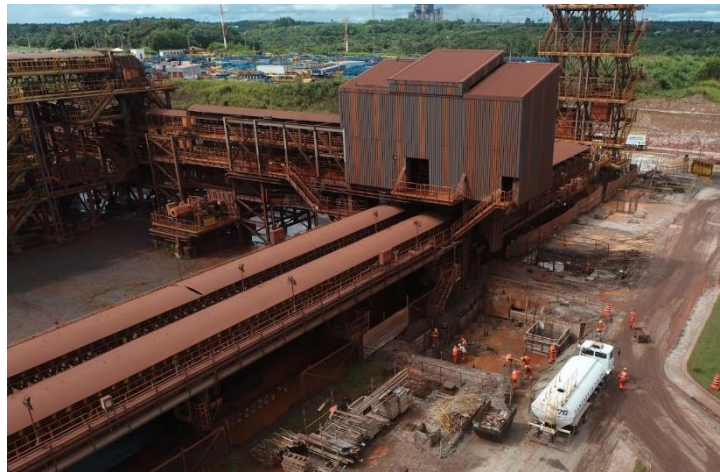
Figura 37 - Casa de transferência de minério.
