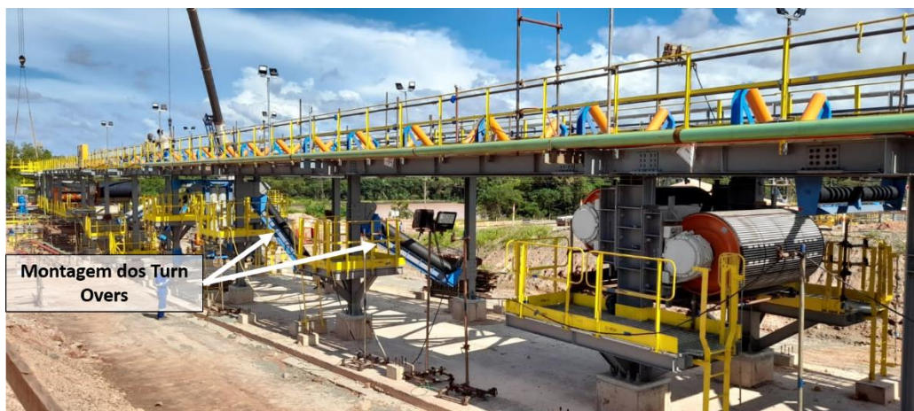
Figura 65 - Montagem dos viradores de correia.
