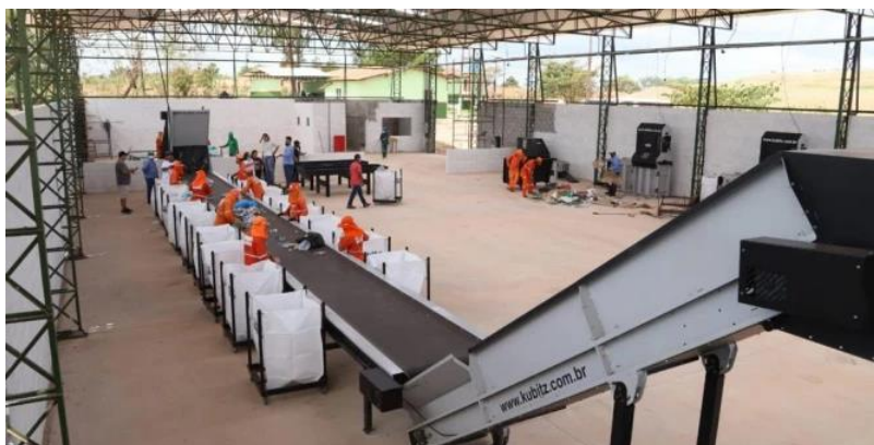
Figura 7 – Central de Triagem de Recicláveis (Centro Ambiental da Ribeira)
