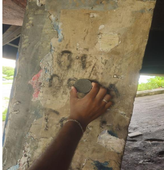
Figura 6: Uso de pedra abrasiva para suavizar superfícies.
