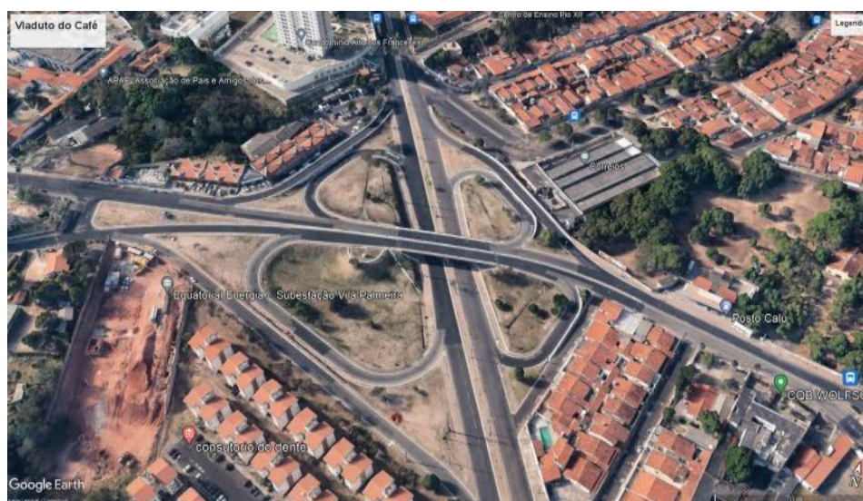
Figura 5: Vista aérea do Viaduto do Café.
