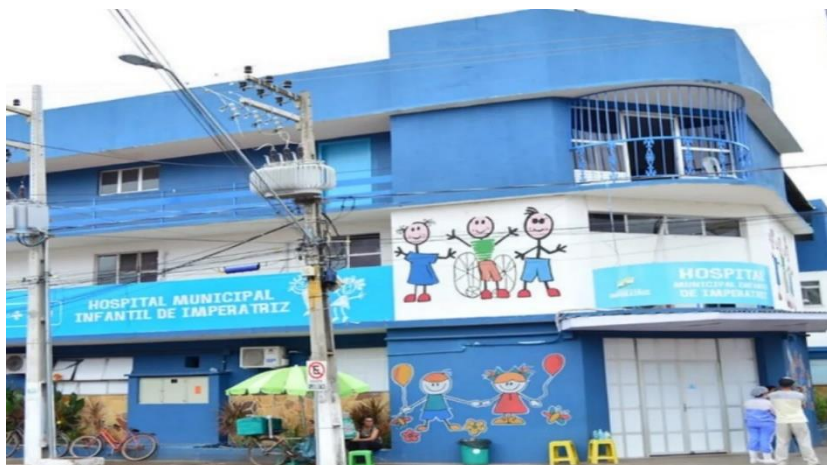
Figura 1 – Fachada do Hospital Municipal Infantil de Imperatriz - MA
