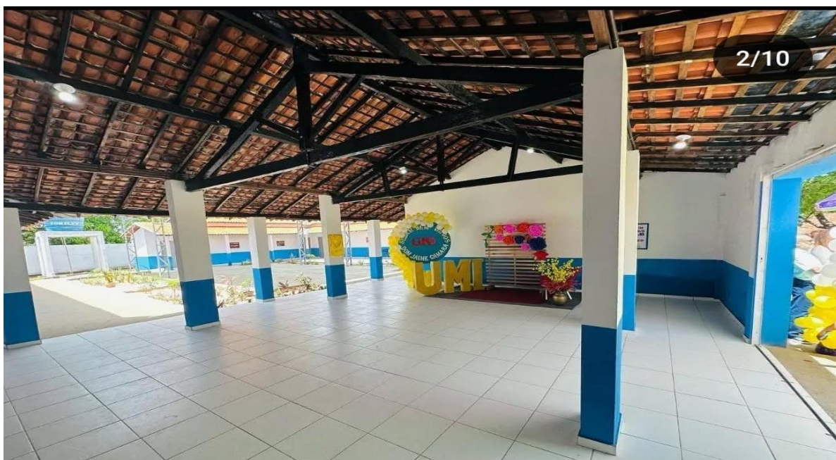
Figura 2 - ÁREA INTERNA DA ESCOLA
