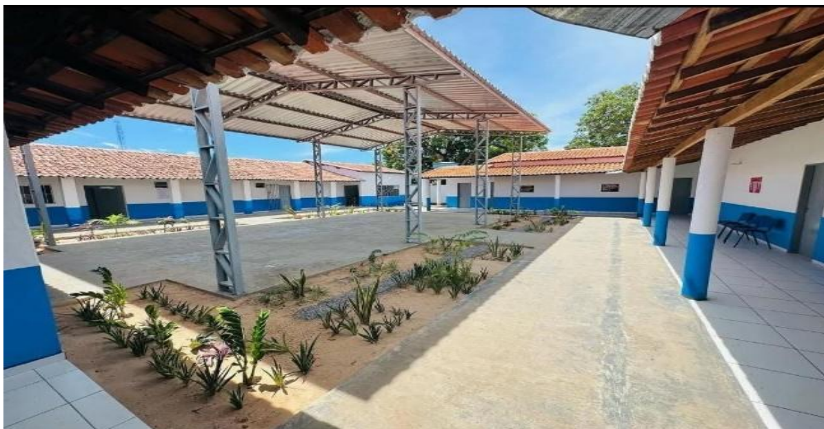
Figura 3- ÁREA INTERNA DA ESCOLA
