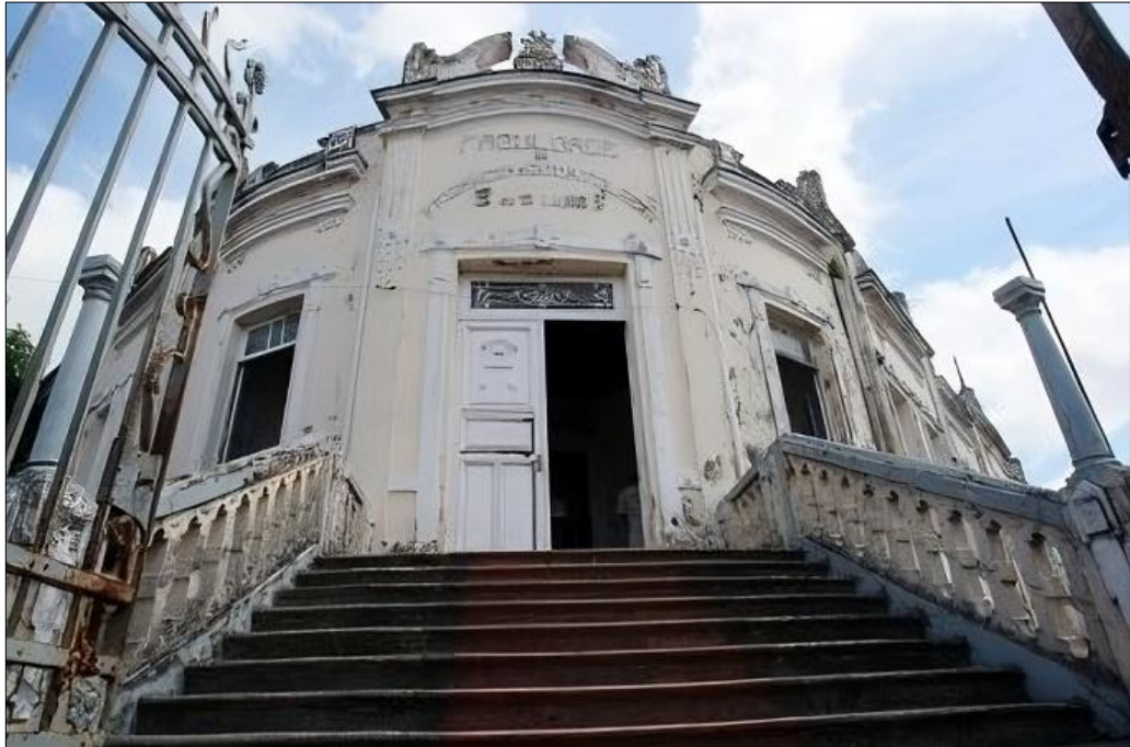
Figura 28: Atual edifício do Palácio das Lágrimas.
